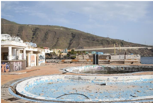
Foto 59. Piscinas artificiales. Vista general
