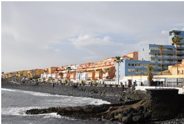
Foto 65. Caseta de bombeo y canalización. Vista desde el interior de la parcela de Tenerife Tour_2
