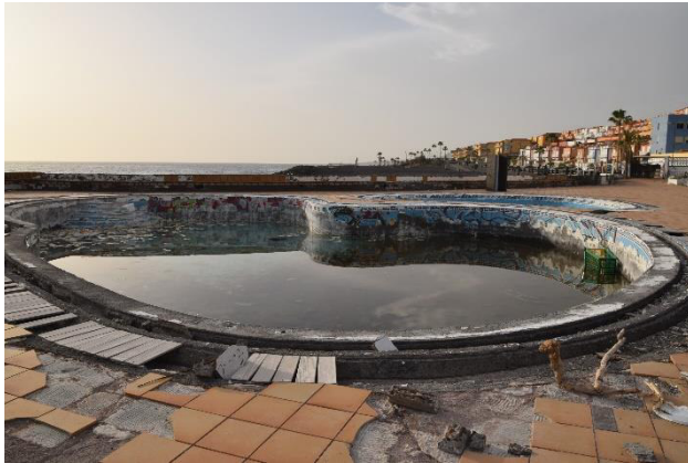
Foto 55. Piscina artificial_2. Detalle
