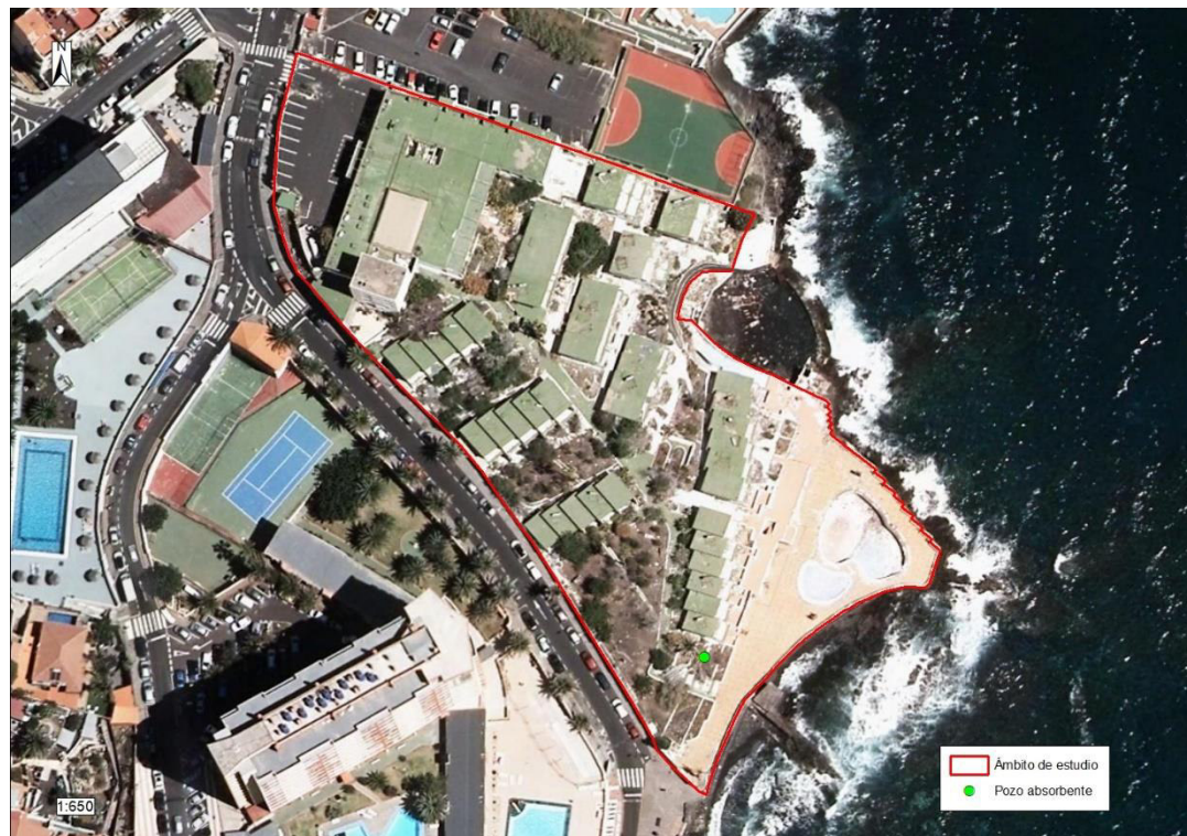
Imagen 54. Localización de pozo absorbente existente
