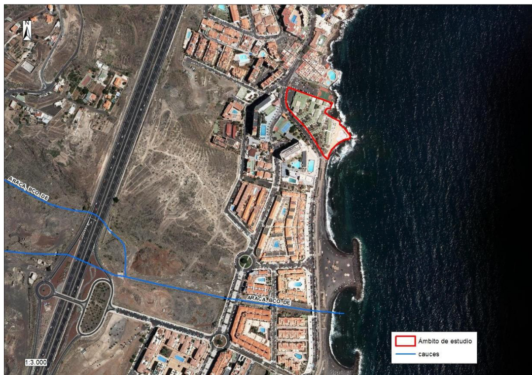
Imagen 10. Cauce de barranco más próximo al ámbito de estudio
