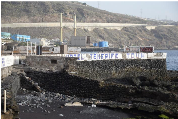
Foto 63. Caseta de bombeo y canalización. Vista desde acceso a la parcela de Tenerife Tour
