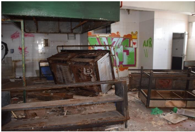
Foto 43. Edificio principal_ 5. Cocina
