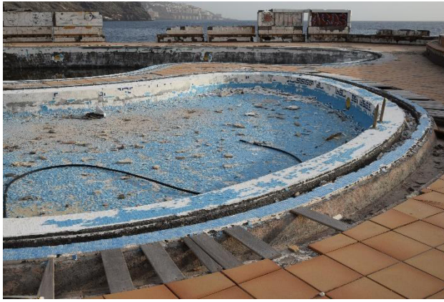
Foto 53. Piscina artificial_1. Detalle
