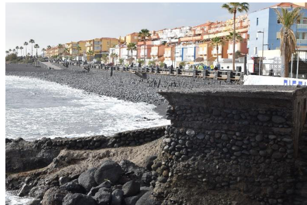
Foto 64. Caseta de bombeo y canalización. Vista desde el interior de la parcela de Tenerife Tour_1
