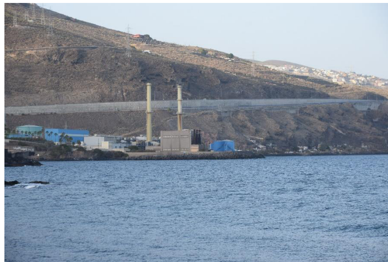
Foto 9. Central Térmica de Caletillas
