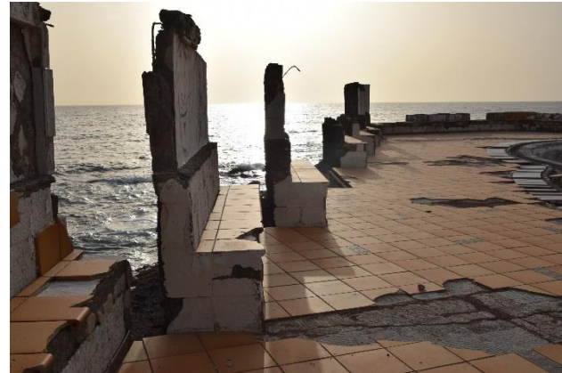
Foto 56. Bancos anexos a las piscinas
