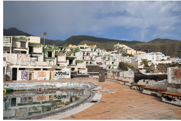
Foto 36. Vista parcial piscina grande, losetas y bancos
