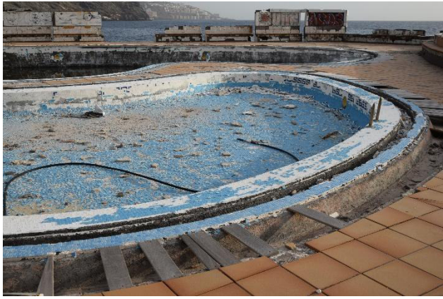
Foto 29. Piscina artificial_1. Detalle
