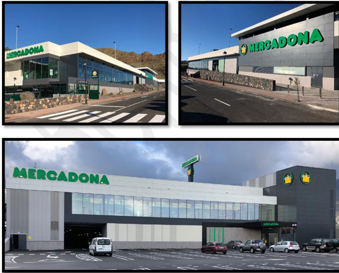
Imagen 15. Ejemplos Tipo Edificación Comercial - Empresa Promotora
