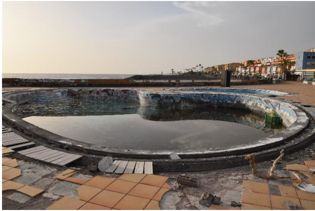
Foto 31. Piscina artificial_2. Detalle
