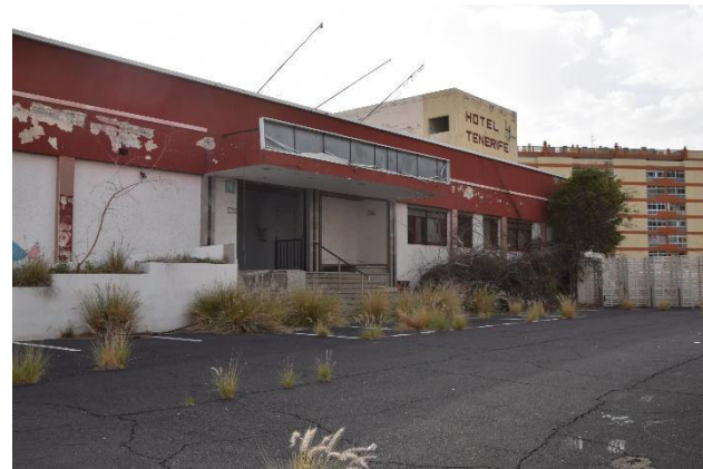
Foto 22. Entrada edificio principal
