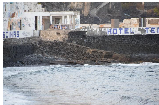
Foto 42. Caseta de bombeo y canalización. Vista desde Paseo Marítimo
