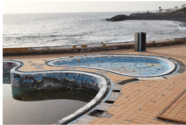
Foto 34. Piscina artificial pequeña. Vista general
