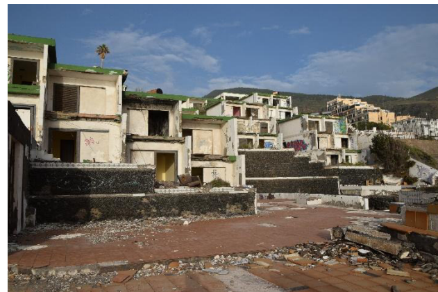
Foto 10. Edificio más próximo a las piscinas artificiales_2
