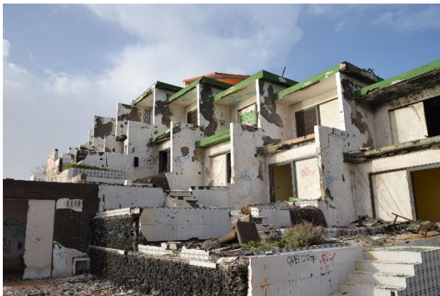
Foto 11. Edificio más próximo a las piscinas artificiales_3
