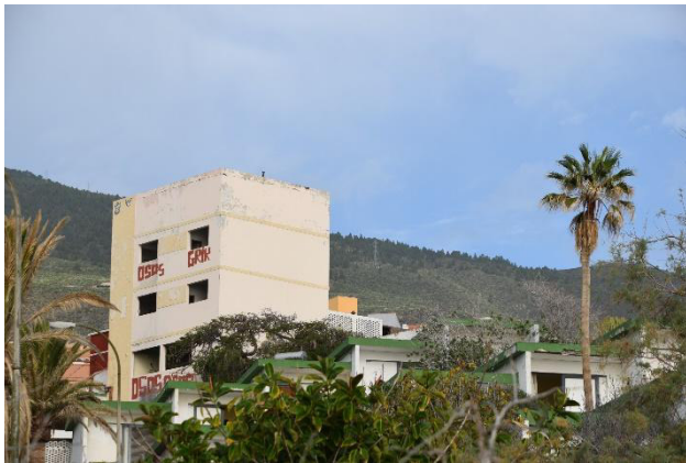
Foto 21. Vista apartamentos y edificio principal
