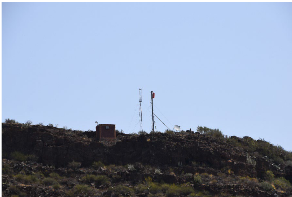
Ilustración 7. Antenas de telecomunicaciones en el AR CAN_06, en el límite oeste del ámbito del PE Vera de Iguste
