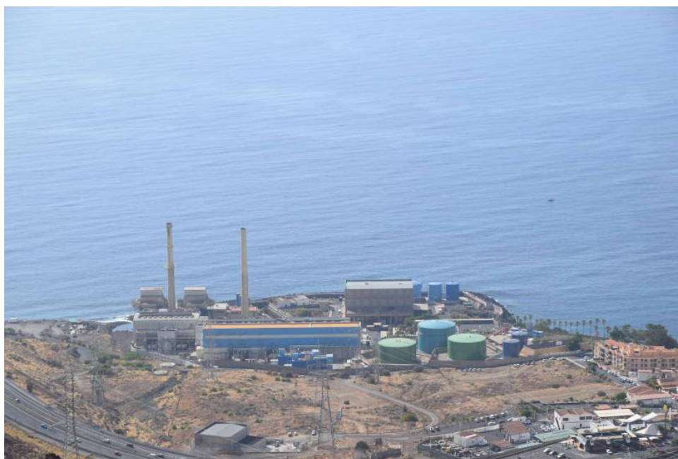
Ilustración 49. Central Térmica de Las Caletillas.
