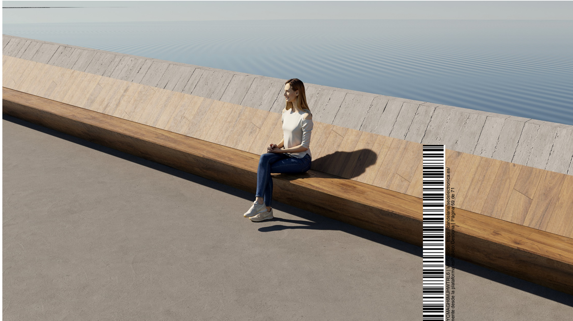
Bancos prefabricados asociados al parapeto del paseo marítimo.
