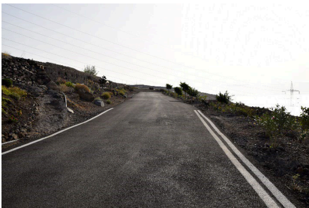
Imagen 7. Tramo de viario asfaltado
