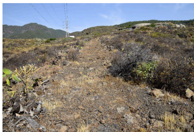
Imagen 10. Pista de acceso a torre de alta tensión
