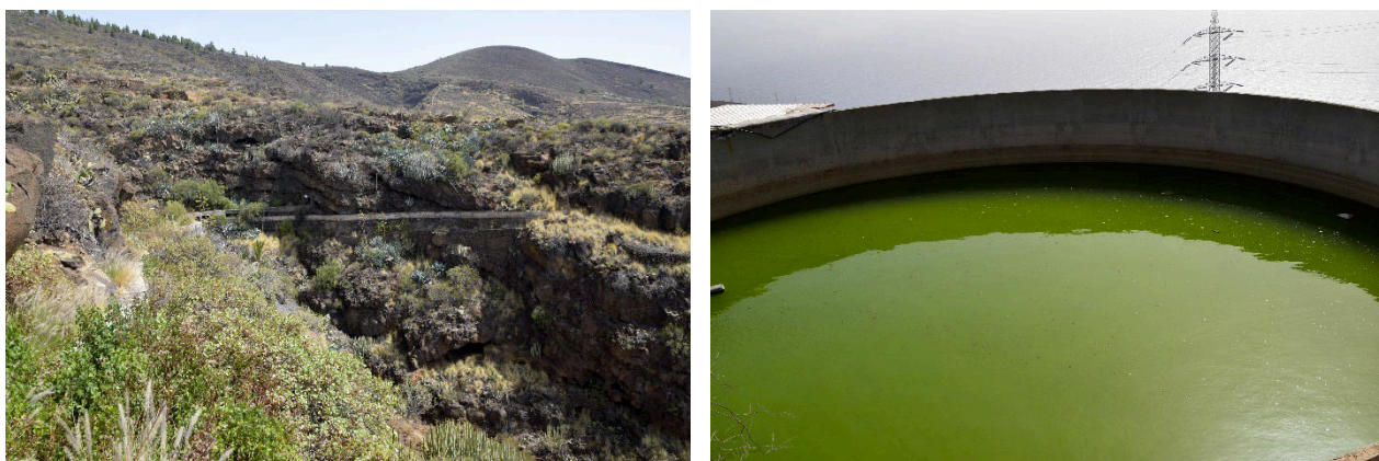
Imagen 14. Diferentes tramos del canal y estanque
