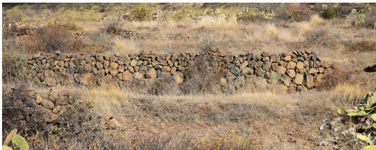
Imagen 26. Plano e Imagen 1 Elementos singulares de Interés. Otras Construcciones: muros de mampostería
