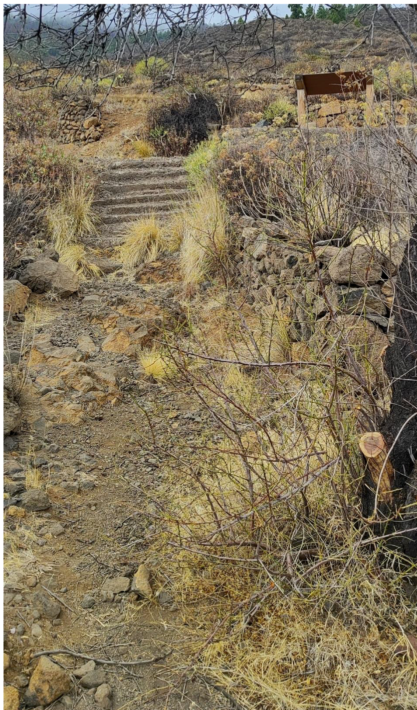
Foto 4. Entrada a la zona de Pasacola: escalera que conecta el Caserío con el Camino Viejo de Candelaria. Fuente: propia.
