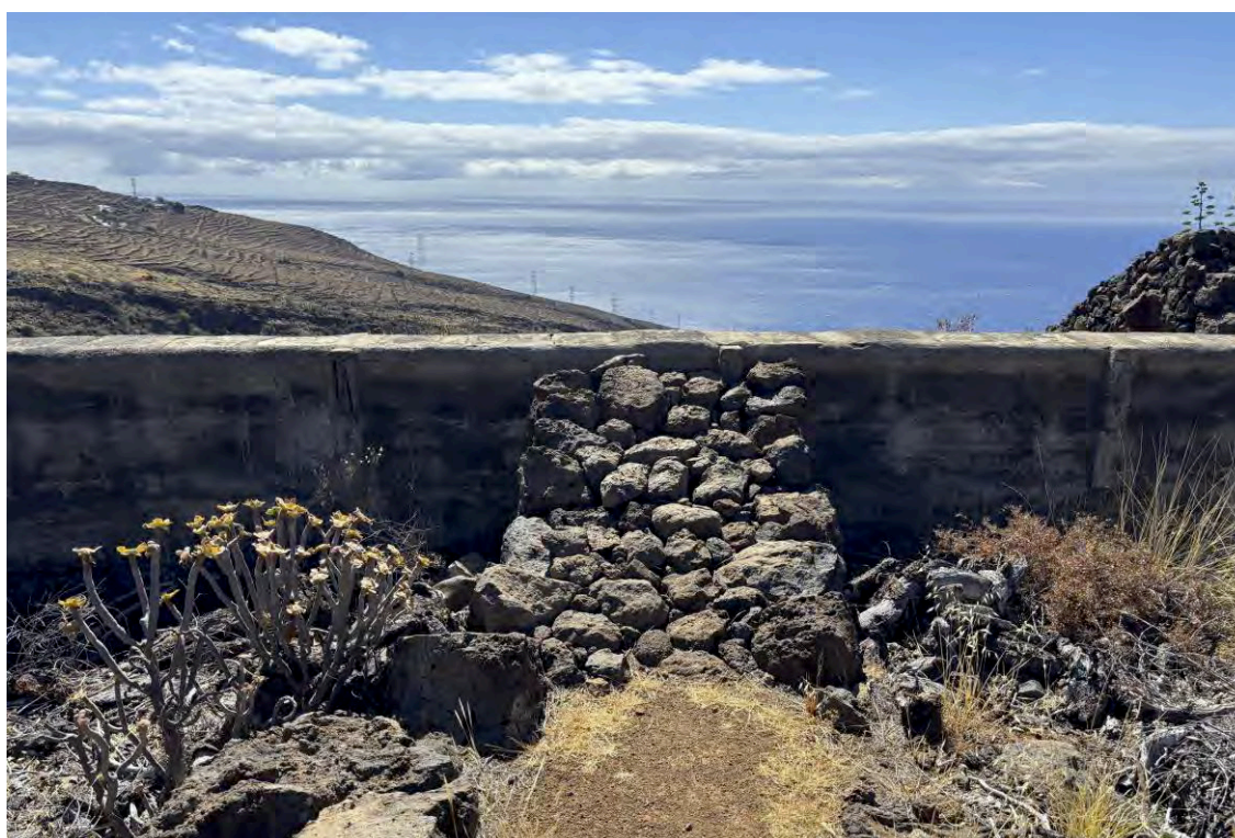
Rampa del sendero que salva el canal a su paso por el caserío de Pasacola
