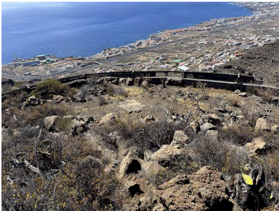
Tramo de canal al sur de Psacola
