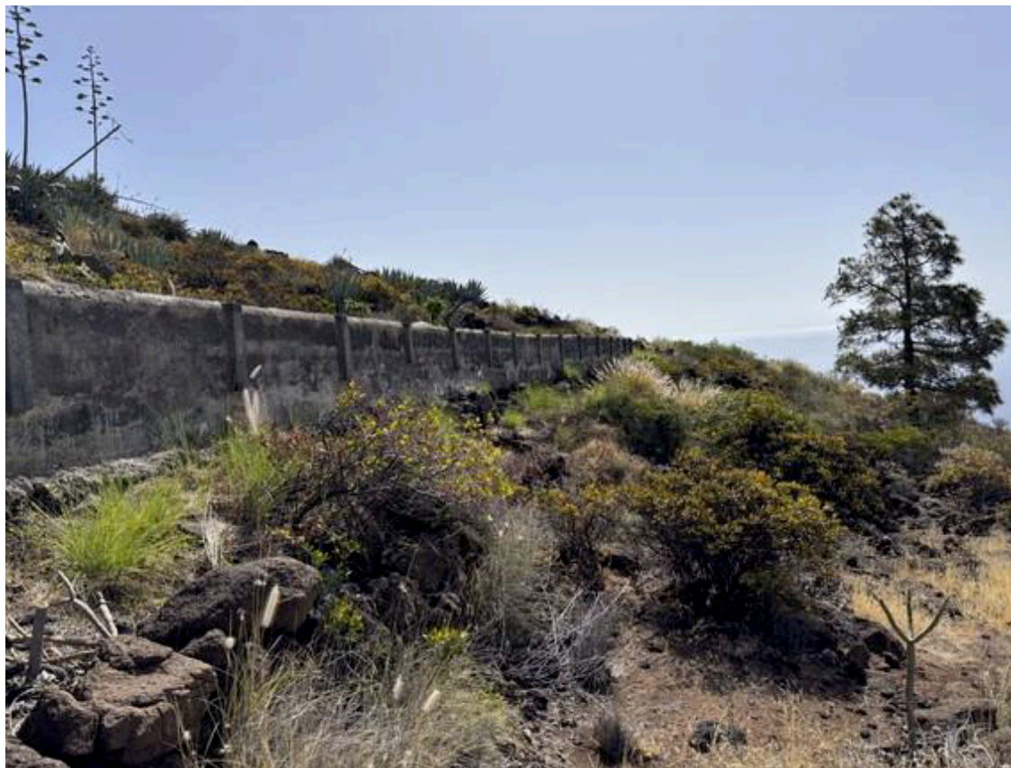
Fotografía de un tramo del canal CA-08V
