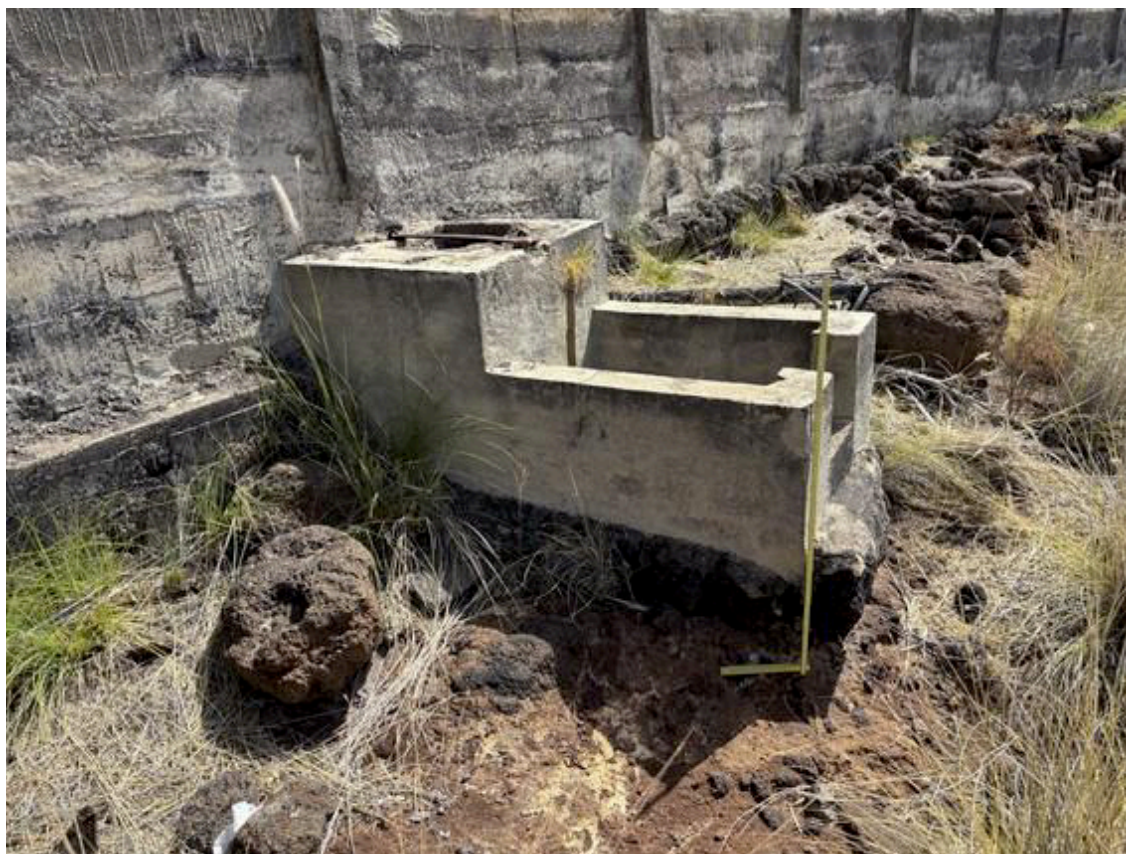
Fotografía general de la tanquilla CA-02V
