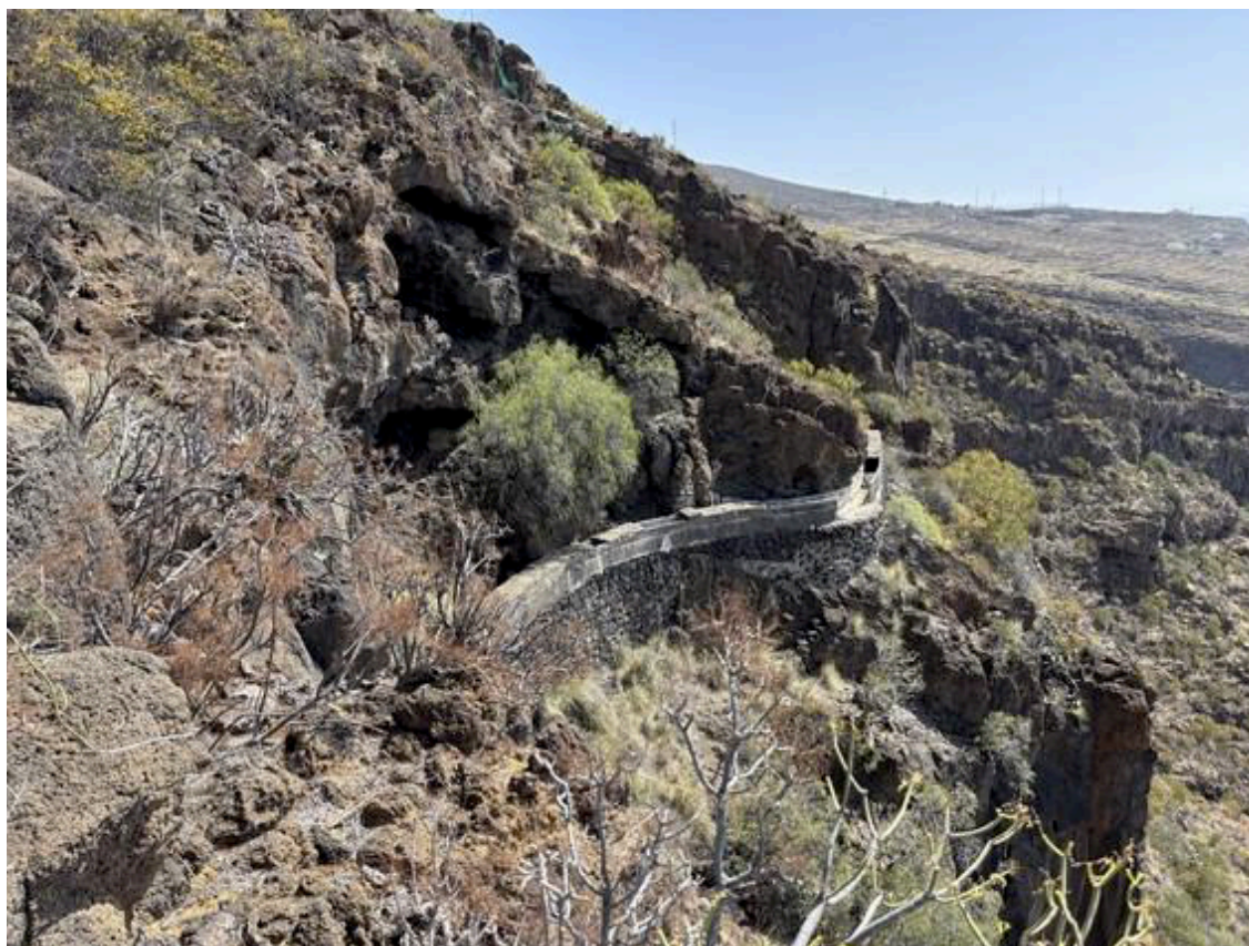
Fotografía de un tramo del canal CA-09V
