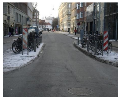
Estrechamientos de calzada
