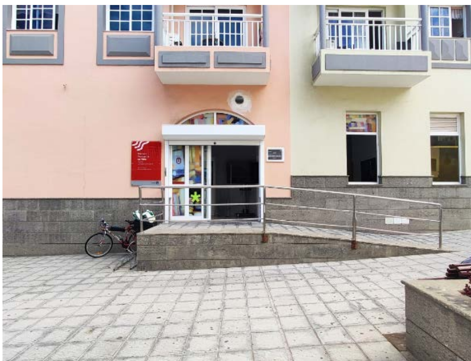
Figura 2. Acceso a la instalación
