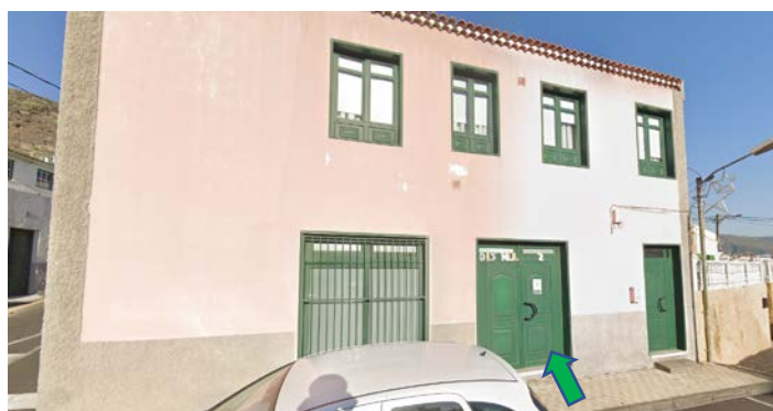
Figura 3. Acceso a la instalación.
