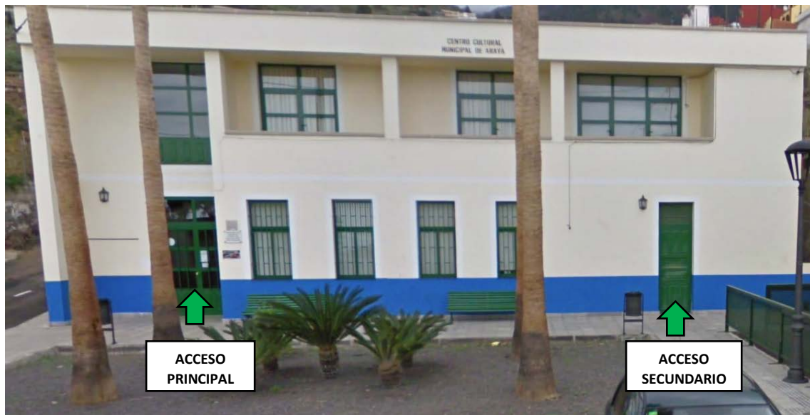
Figura 3. Acceso a la instalación.
