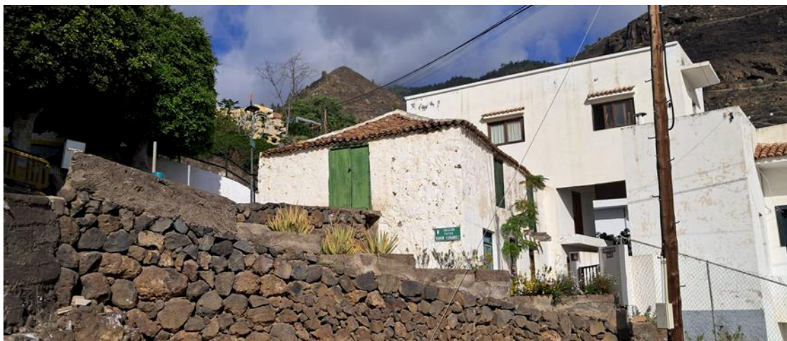
Ilustración 86.- Predominio en fachadas del muro ciego frente a los huecos que son irregulares y no ordenados
