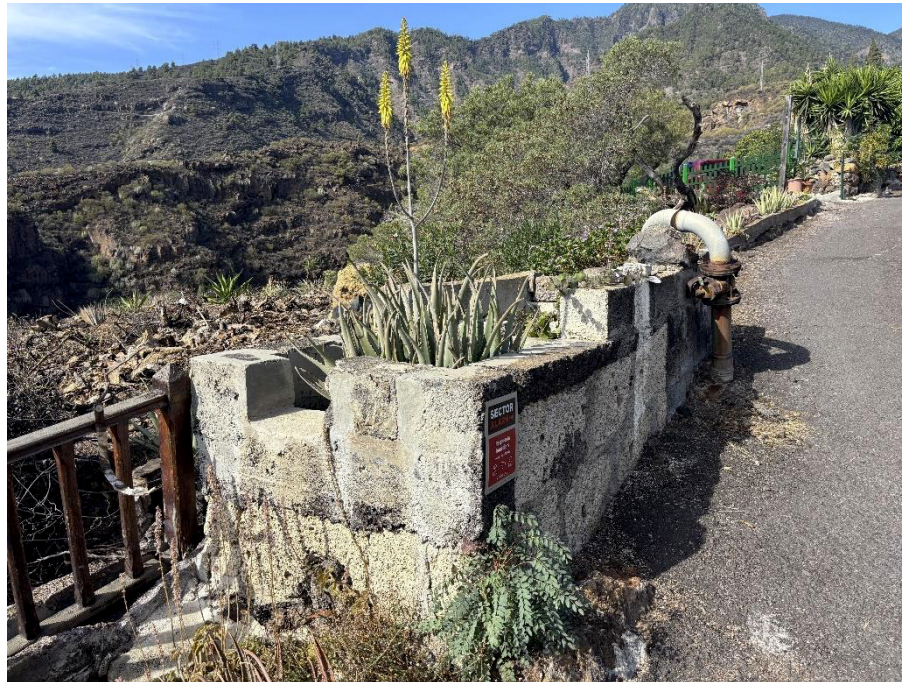
Ilustración 97.- Pesadora-distribuidora de agua (código ET-02).
