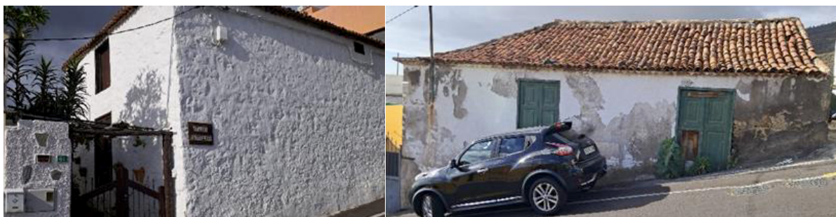
Ilustración 85.- Imagen izq. Fachada proyectada ciega hacia la calle y huecos desiguales en su lateral. Imagen dcha. Fachada hacia la calle con huecos desiguales
