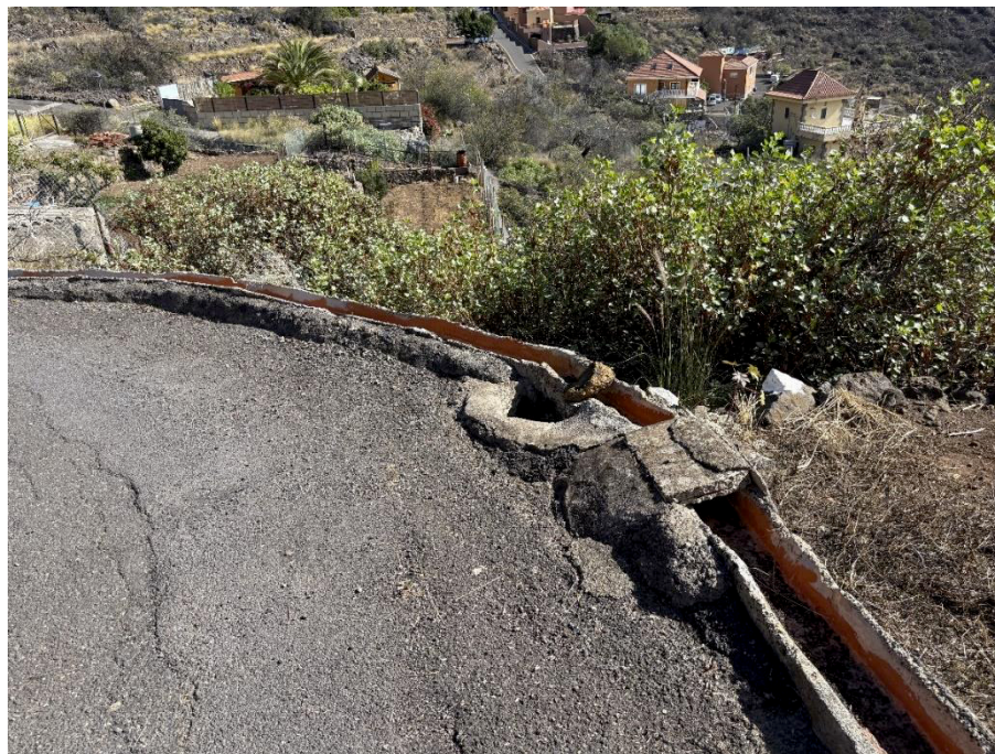
Ilustración 98.- Tramo de canalización de agua (código ET-03).
