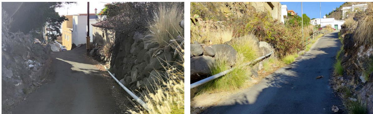
Ilustración 106. Cauce Barranco El Fuerte ocupado por calle La Estila. Fuente: Elaboración propia.
