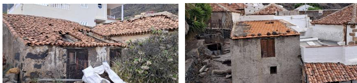
Ilustración 91.- Tipos de cubiertas inclinadas a distintas aguas
