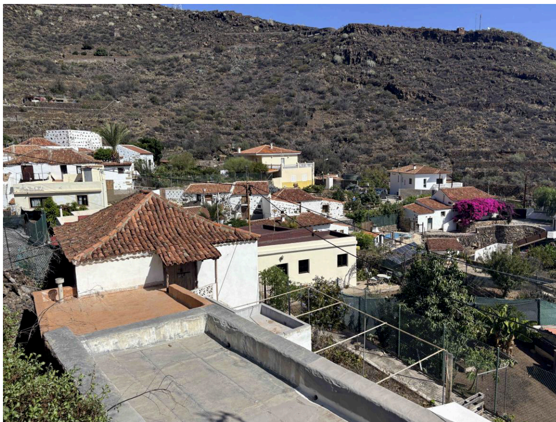
Vista general del caserío de La Jiménez
