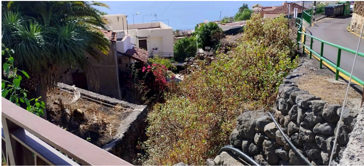
Ilustración 37. Imagen de la situación actual del cauce del barranco de El Fuerte, también conocido como de La Jiménez.
