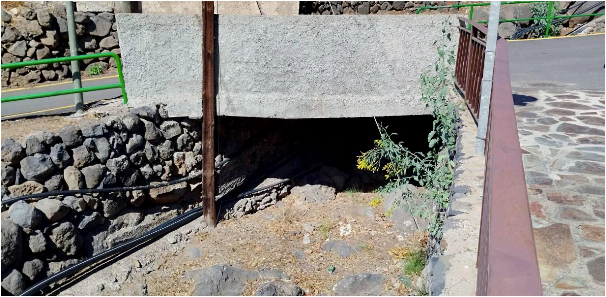
Ilustración 6. Barranco de Los Mocanes y la obra de paso de la calle La Jimenez.
